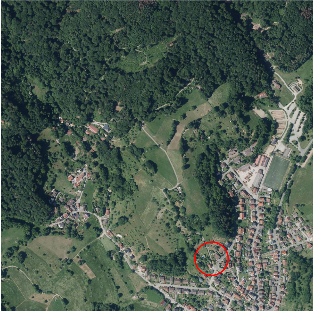
Abbildung 23 Luftbild des Teilgeltungsbereichs 2 und der näheren Umgebung (unmaßstäblich, Bildquelle: Hessische Verwaltung für Bodenmanagement und Geoinformation, Download vom 29.08.2023 unter https://www.gds.hessen.de/ )
